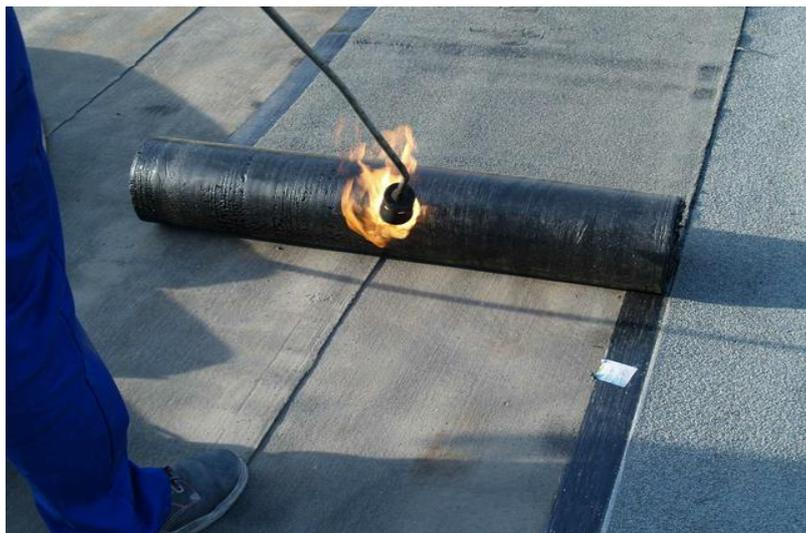
Рубероид известен невероятно давно. Его использовали десятилетия назад в качестве материала, который обеспечивает прекрасную гидроизоляцию кровли или вовсе выступает конечным кровельным покрытием. Но сегодня на смену этому классическому материалу пришел еврорубероид. Такой материал обладает особенно интересными характеристиками, которые позволяют использовать его во многих случаях.
