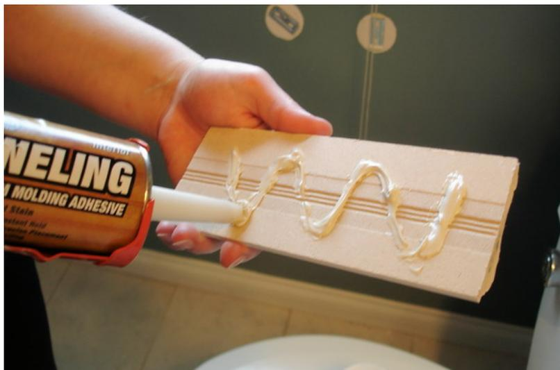
Жидкие гвозди это состав, который имеет свойство быстро высыхать, обладает высокой прочностью, что делает данный материал очень популярным в строительной сфере. Жидкие гвозди характеризуются водостойкостью и довольно устойчивы к высоким температурам. Даже если в помещении повышенная влажность данный материал хорошо скрепляет поверхности. Жидкие гвозди устойчивы к коррозии и не подвержены возникновению грибка.
