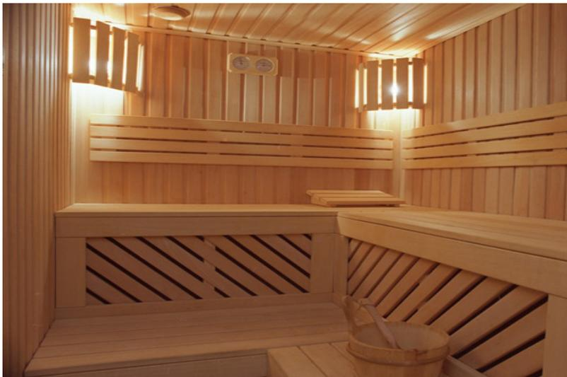
Применение вагонки в качестве отделочного материала для стен не отличается особенной сложностью. В первую очередь нужно определить, по какой технологии будет проводиться данное мероприятие. Первым вариантом является закрепление панелей непосредственно на поверхность стены, если она хорошо выровнена.
