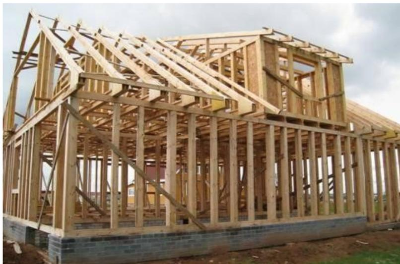
Каркасные дома это легко возводимые конструкции, малоэтажного типа. По каркасной технологии сегодня строятся не только частные домовладения, но и многофункциональные, большие здания.
