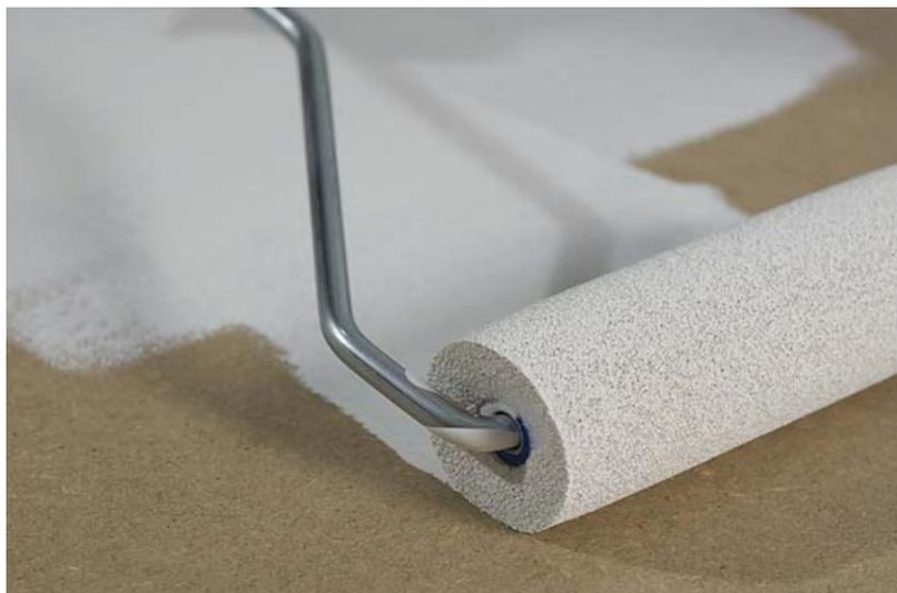
Выполнение отделочных работ в большинстве случаев требует применения грунтовки. Этот материал позволяет создать надежную основу под отделочное покрытие, а также сделать его сцепление с основанием более долговечным и стойким. Но ассортимент грунтовочных растворов сегодня крайне велик. Выбирать конкретный материал требуется очень внимательно.
