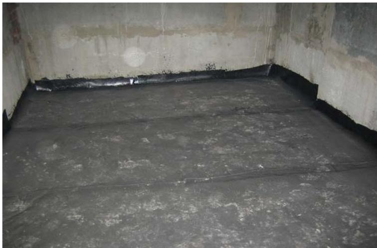
Важность гидроизоляции полов хозяева жилищ обычно не понимают. Поэтому они не видят особенных различий между технологиями обустройства пола в гостиной и в ванной. А они, на самом деле, невероятно велики. Если не провести качественную гидроизоляцию пола в помещении, где воздух обладает высокой влажностью, могут возникнуть достаточно серьезные негативные последствия через некоторый период.
